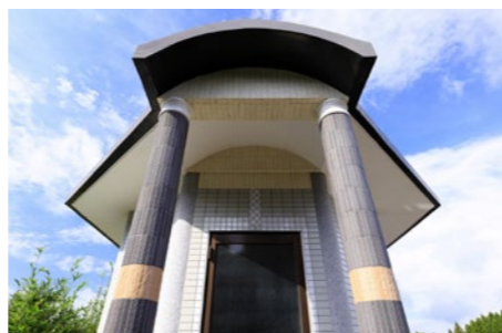
自宅の敷地内に立つ大きな納骨堂はコンクリート製で耐震性も抜群。自分たちが生業としている左官業の技術と先祖への感謝、代々へ受け継ぎたい思いを最大限に込めて、親子一丸で作上げた。
