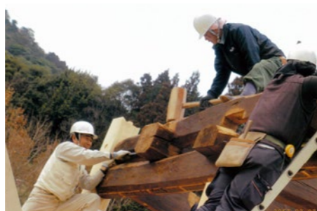
古材を再利用するなど、環境にも配慮した佐伯市W氏邸の新築現場。木の良さを最大限に生かし、日本の気候風土に適した家づくりを得意とする『染矢建築』の職人の技で、1棟ずつ丁寧に造りあげられていく。
